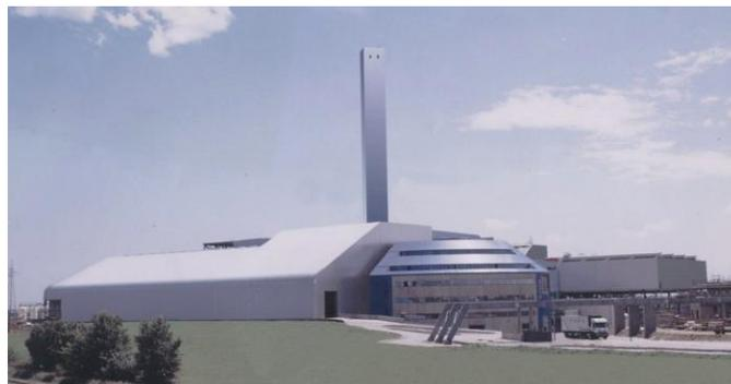
Il Termoutilizzatore della ASM di Brescia è un impianto destinato, attraverso la combustione di Rifiuto Solido Urbano (RSU) e a valle di una diffusa raccolta differenziata, alla produzione di energia elettrica ed acqua calda per la rete urbana di teleriscaldamento, che serve attualmente circa 120.000 abitanti.
